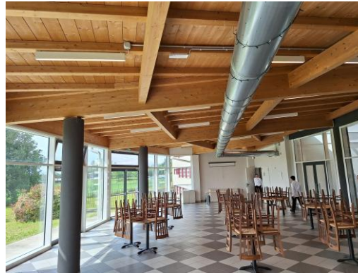
Olmo di Cornaredo – efficientamento energetico
