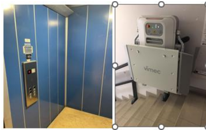
Curie Sraffa di Milano sostituzione ascensori, montascale
