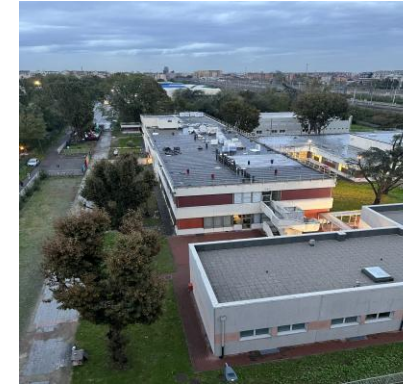
Vespucci di Milano – rifacimento coperture
