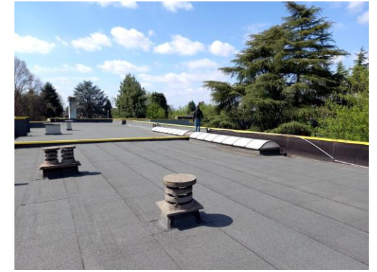
Falcone Borsellino di Arese – Coperture e impianti elettrici
